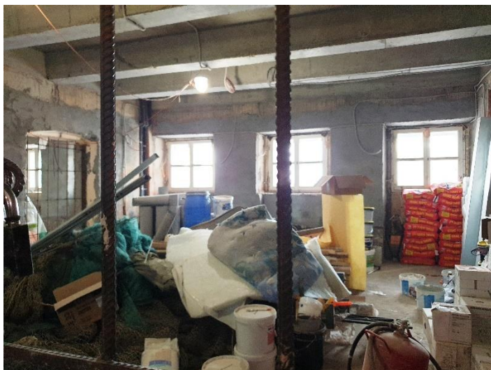
Фото 39. Строй-объект «1-5»: будущий 105 класс третьего корпуса. 13 мая 2021 г.
